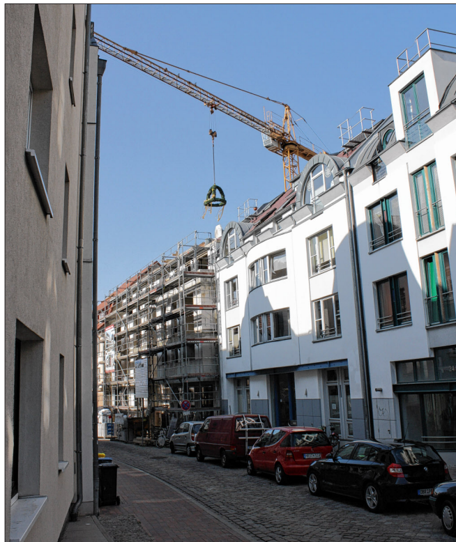
Nun rückt der Einzug fast schon in greifbare Nähe: Der Rohbau des Stadtcarrés ist fertig.
